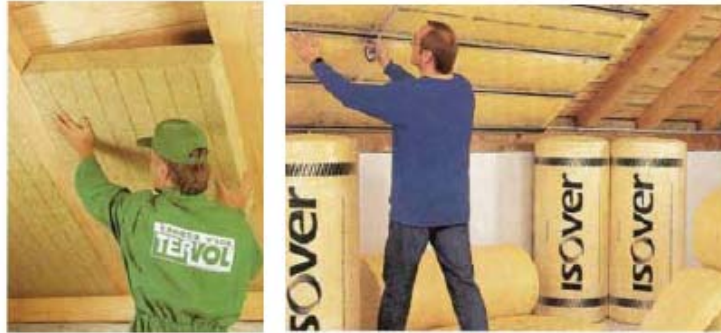
Слика 24 Топлинска изолација на кос кров кај негреано поткровје
