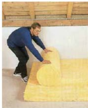
Слика 23 Топлинска изолација на под кај негреано поткровје
