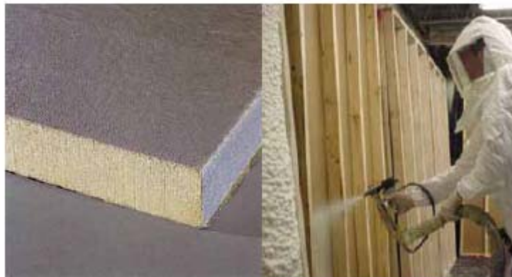
Слика 9 PUR – полиуретан во плочи и прскан полиуретан
