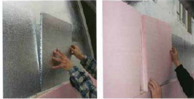
Слика 14 Вакумско изолациони плочи од надворешна страна на сидот – заштита на плочите од надворешна страна
