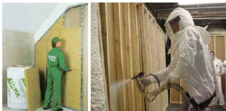
Слика 32 Топлинска изолација на лесни ѕидови кон негреан простор
