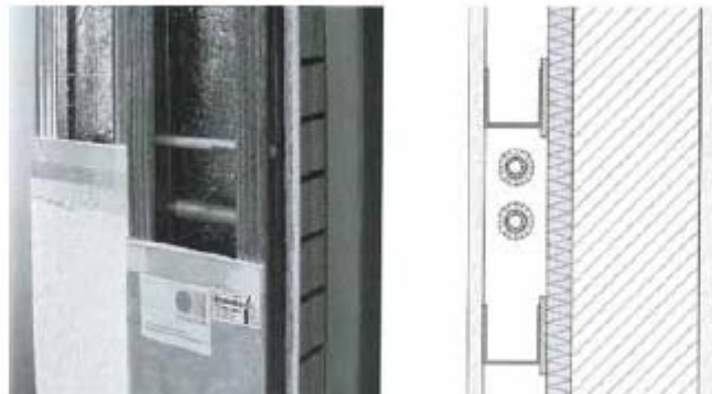
Слика 15 Вакумско изолациони плочи на внатрешна страна на сидот – споевите мора да се прилепат со самолепливи фолии поради постигнување на ефикасни парни брани, плочите треба да се заштитат од оштетувања (пробивање на фолијата)
